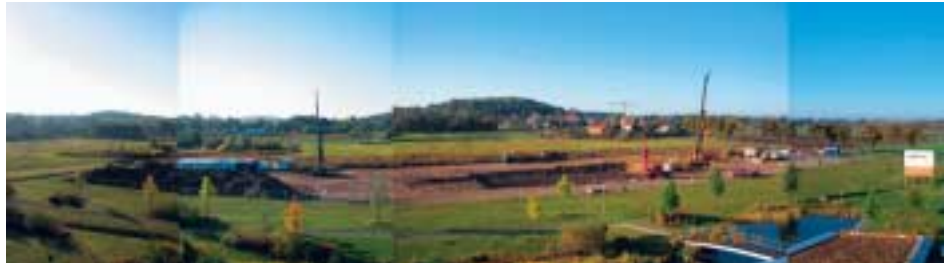
Aushub der Baugrube Anfang Oktober 2004.
